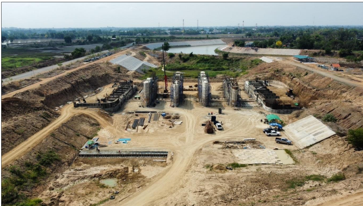
ภาพที่ 1.9-1 การก่อสร้างประตูปรับน้ำห้วยงาน และอาคารประกอบ
